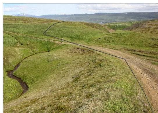
Mynd 13: Horft norður pípastæðið við Torfnalæk. Vatnsveituvegurinn sveigir upp með Fossilæk.
