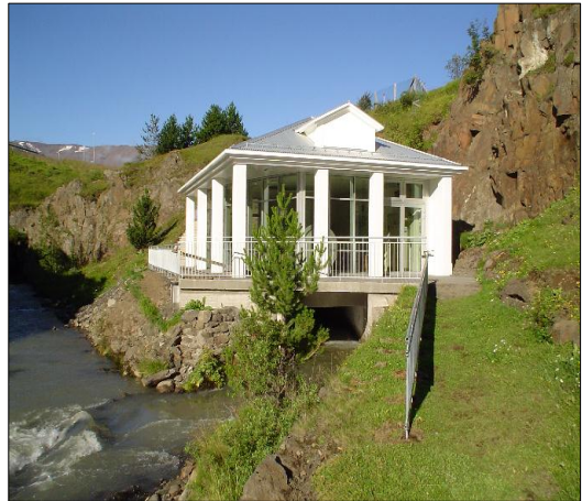
Mynd 1 Stöðvarhús Glerárvirkjunar
