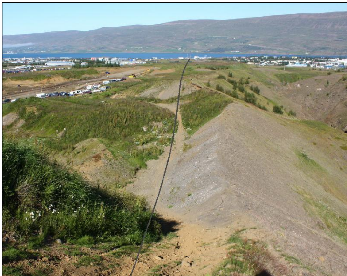
Mynd 10: Horft niður með pípastæðinu skammt neðan jöfnunarþróar. Pípa liggur í röskuðu landi allt að Réttarhvammi.
